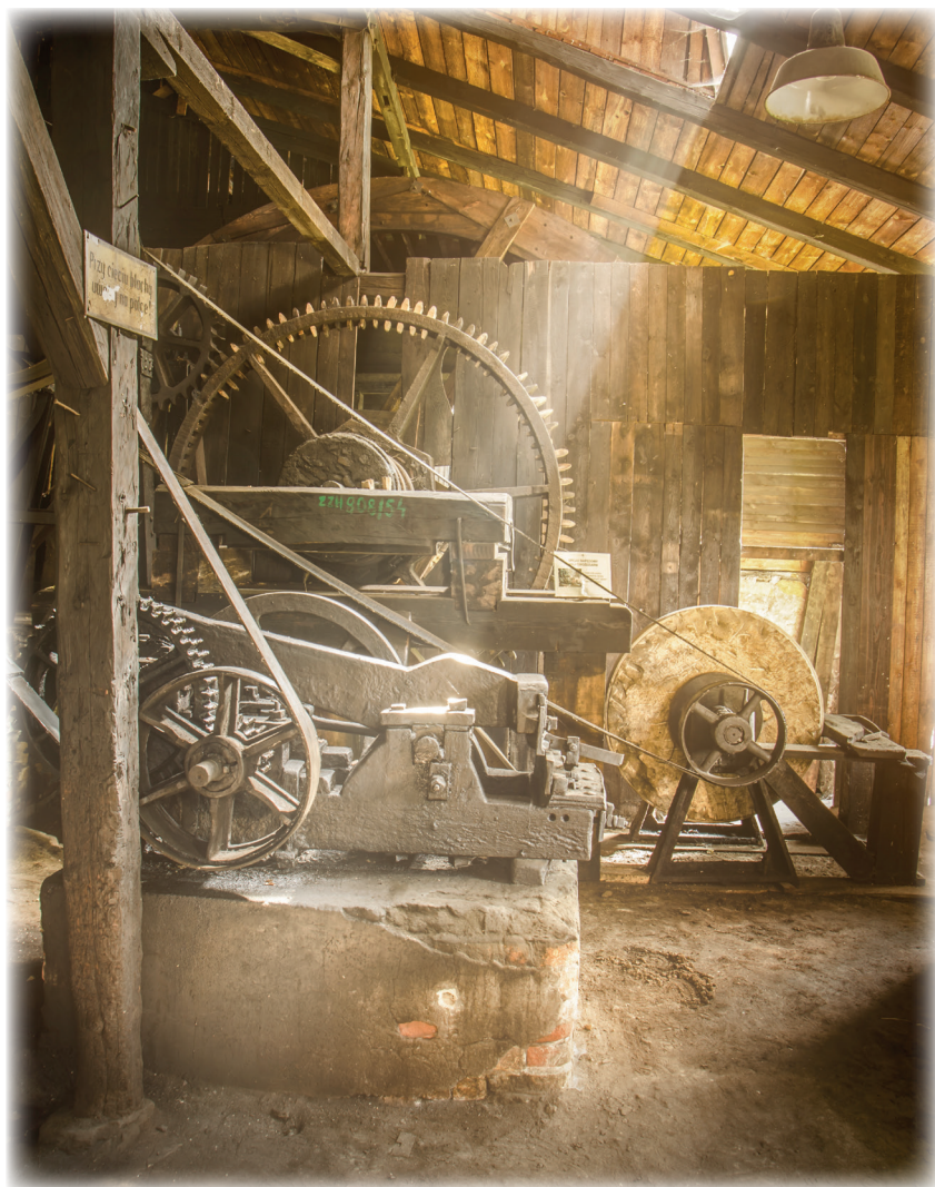
Małe koło wodne w fabryce żelaza w Maleńcu (2015 r.) Źródło: Zabytkowy Zakład Hutniczy w Maleńcu.
